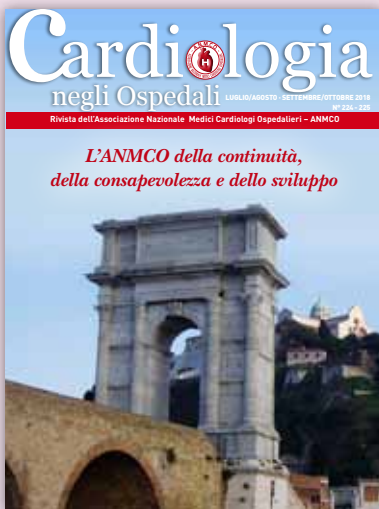
Arco di Traiano, Ancona (II secolo d. C.)
